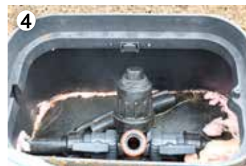
4 Разпределителна водна шахта
