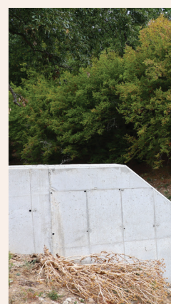
Един от баражите, строен през 60-те години на миналия век (вляво), и новият праволинеен бетонов бараж, изграден през 2022 г. – ГСУ – Каравелово
