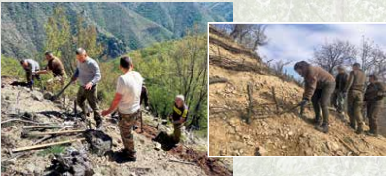
▲ Служителите на РДГ – Благоевград, извършват пролетно залесяване на пороя „Бабин трап“ над с. Крунник. Целта е укрепване на терена и предотвратяване на свлачищните процеси, които при всеки интензивен валеж затварят главен път Е79. В тежките условия на голям наклон и почти пълна липса на почвен слой лесовъдите изграждат плетове и тераси
